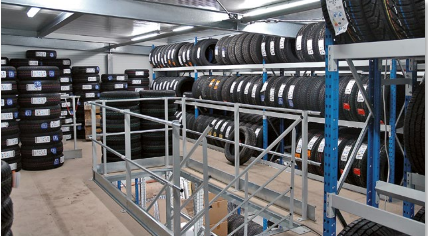
Obergeschoss zur Reifenlagerung, wahlweise frei liegend auf der Bühne oder stehend in Regalen.
