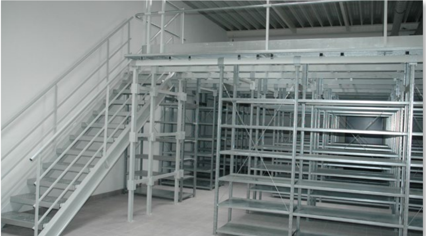
Systembühne auf Fachbodenregalen. Das OG ist frei.
