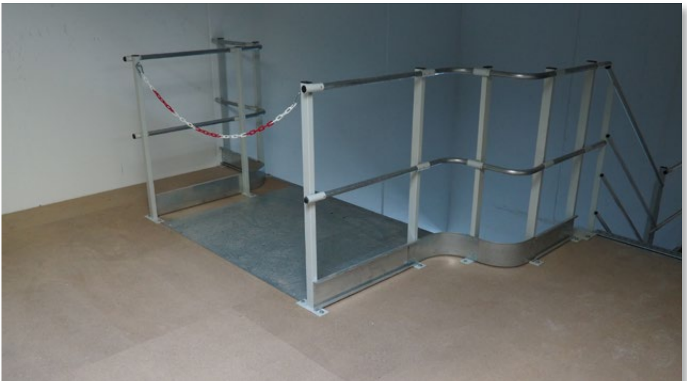
6 Aufgabepplatz im Obergeschoss einer doppelgeschossigen Regalanlage.
