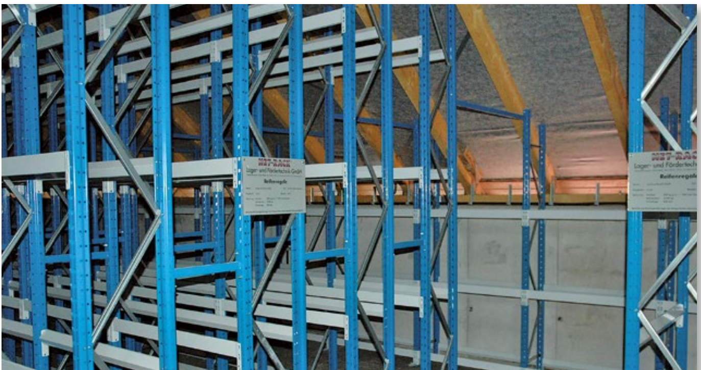
Reifenregale unterm Dach. Höhenanpassung: Kein Problem!
