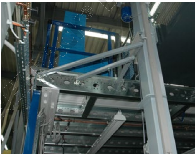
Stabilisierung der Säule an der Bühnenkonstruktion.
