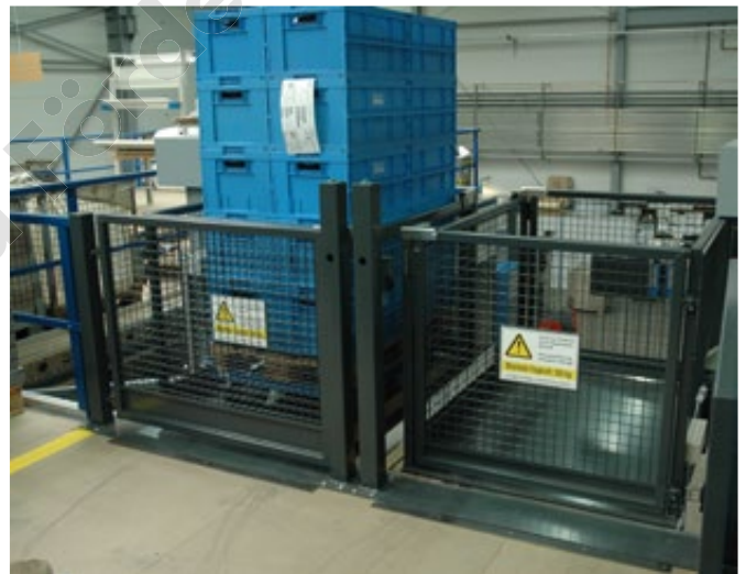
Beschickungsebene auf der Bühne für zwei Lastenheber.
