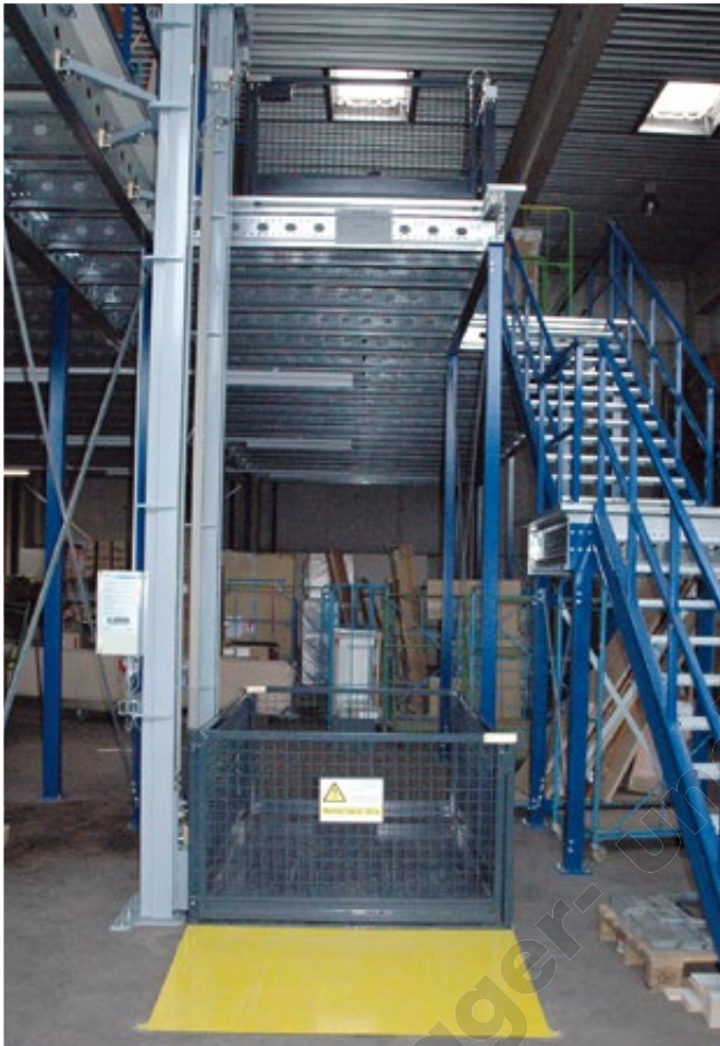
Hubhöhe 4.300 mm, Förderkorb 2.600x 1.500 mm bei einer Möbelspedition.
