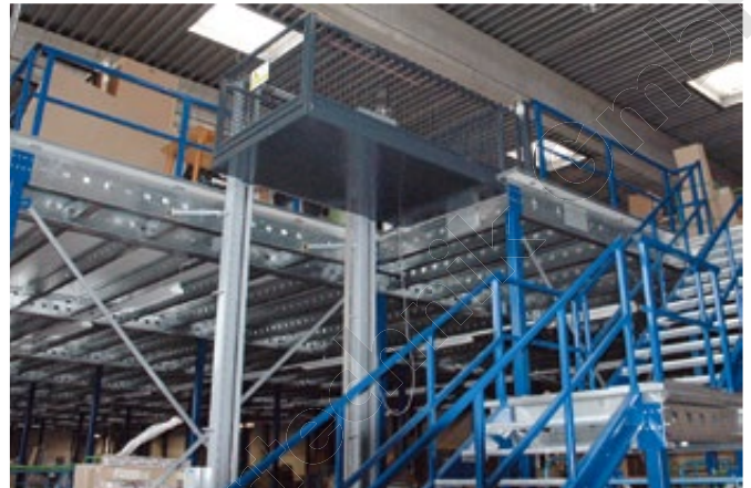
Hubhöhe 4.300 mm, Förderkorb 2.600x 1.500 mm bei einer Möbelspedition.
