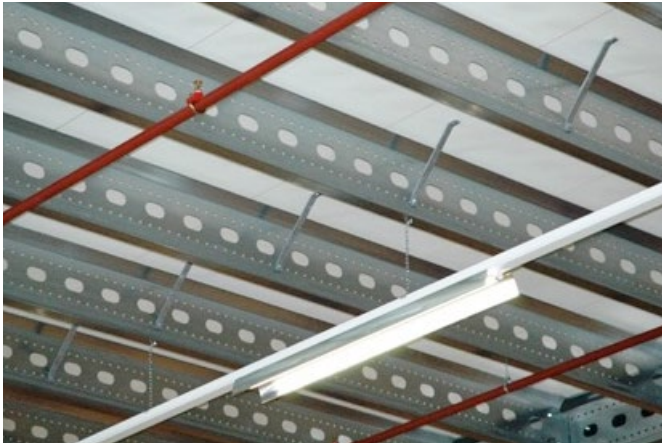
Einfache Verlegung von Versorgungsleitungen mit NET-RACK® Systemprofilen
