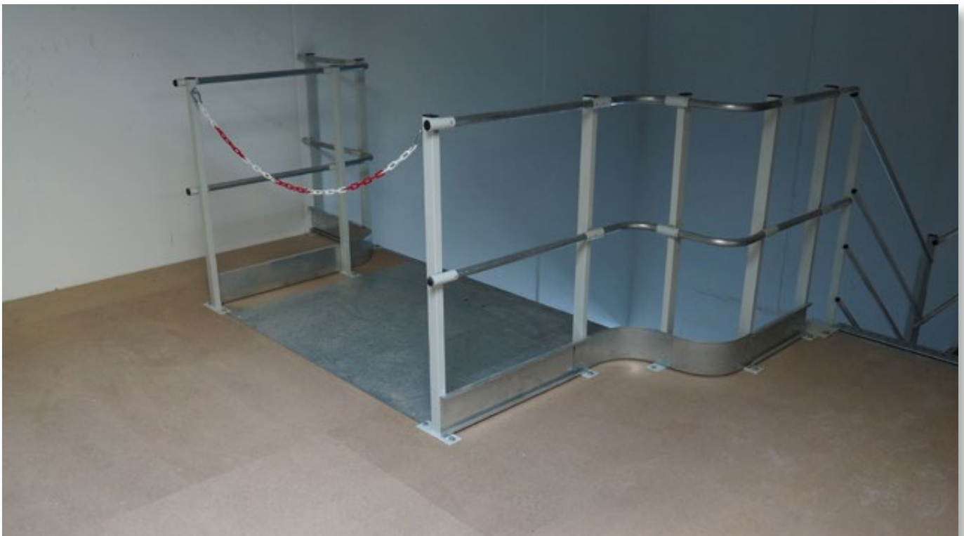
6 Aufgabepplatz im Obergeschoss einer doppelgeschossigen Regalanlage.
