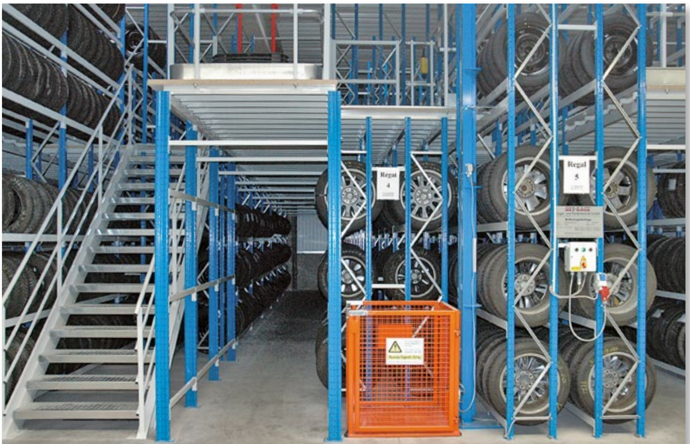
18 Doppelgeschossige Reifenregalanlage mit Reifenlift.
