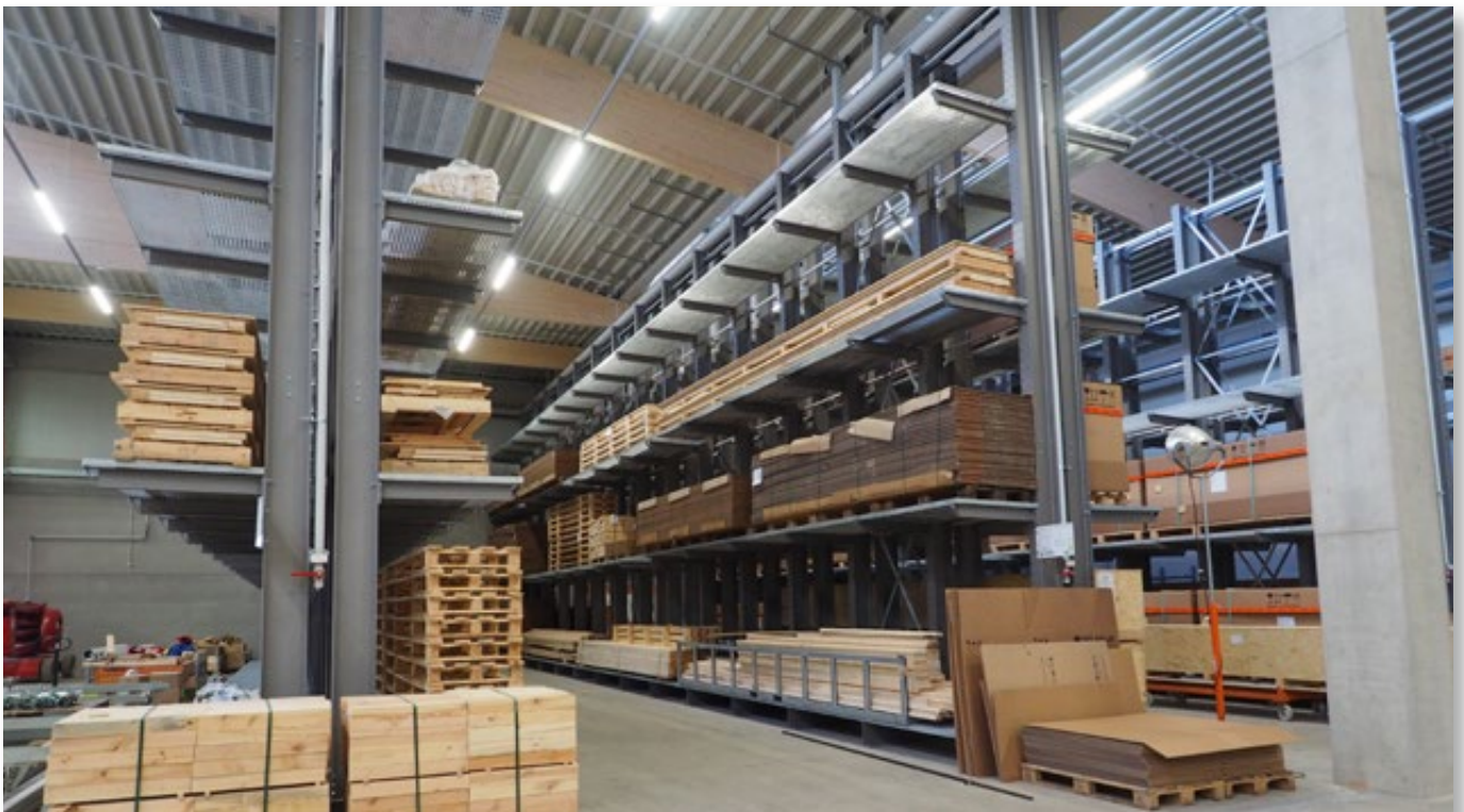
Doppelseitige Kragarmregale für Holzlagerung mit Gitterrosten.
