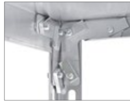
Eckplatten sorgen für Stabilität
